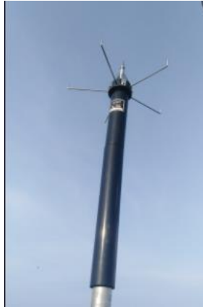
Gambar 3.1 Penangkal Petir
